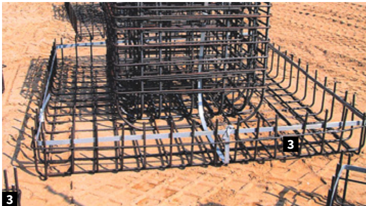
Verlegung von Bandstahl für Erdungszwecke.
